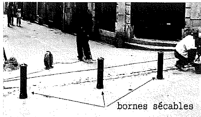
Bornes sécables par un homme sur poussée
